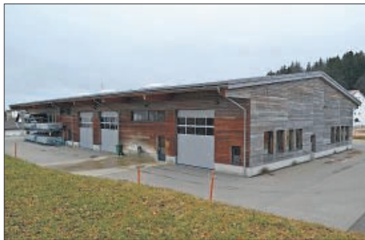
Les panneaux solaires seront installés sur le toit du bâtiment des services techniques de Saignelégier. PHOTO MB
